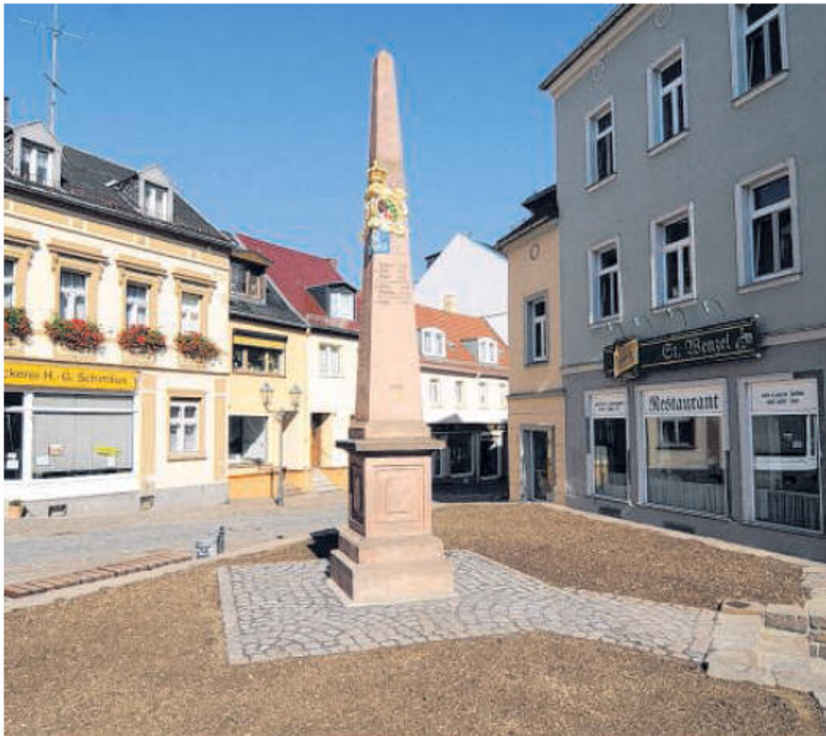
Die restaurierte Postsäule an der Dresdener Straße: Am Tag des offenen Denkmals, am 13. September, wird sie, bestückt mit einer Tafel der Sponsoren, eingeweiht. Foto: Andreas Röse
