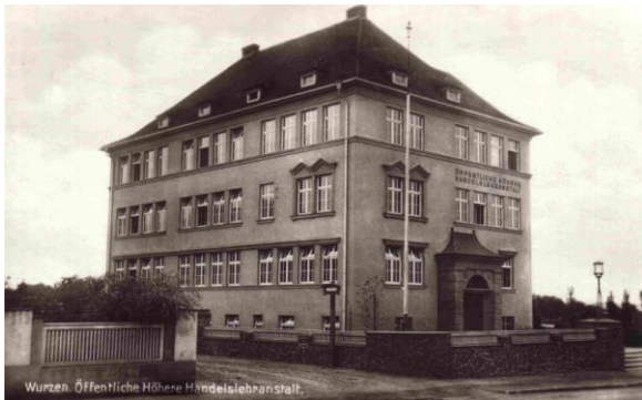
Das Gebäude der Handelsschule in der Seetzenstraße 3
