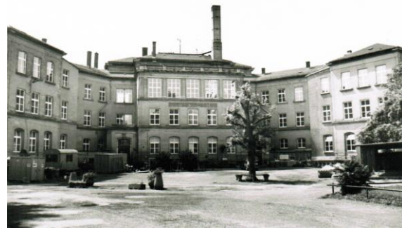
Das Schulgebäude auf dem Domplatz 7/8
