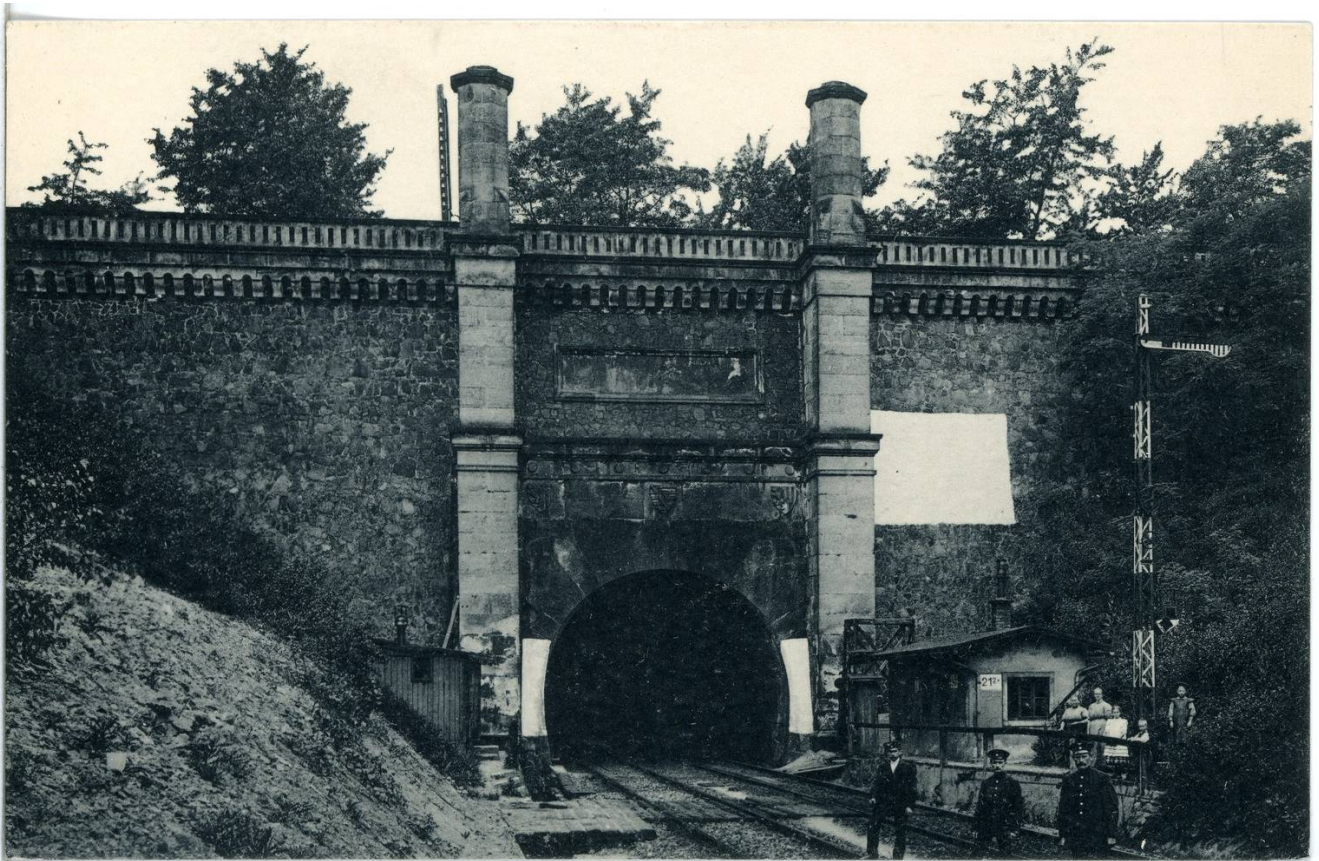
Tunnel bei Oberau
